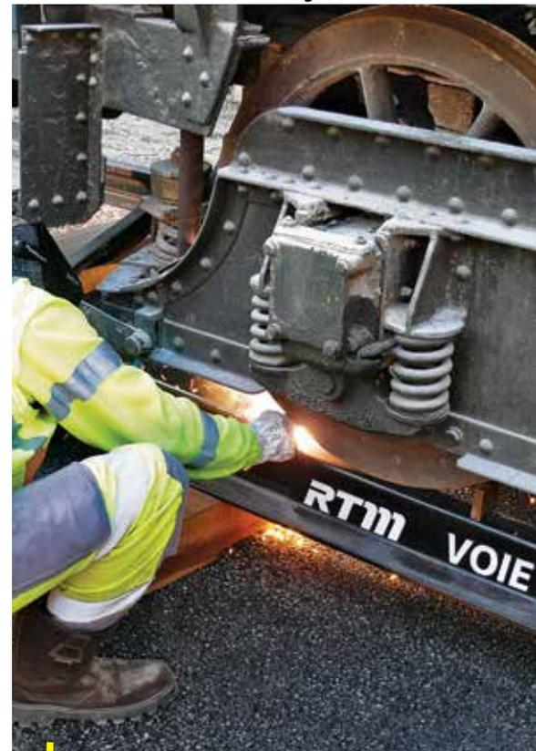
Un technicien de la RTM sécurise la motrice en soudant des cales sur le coupon de rail. Photo : Cédric Garnier
