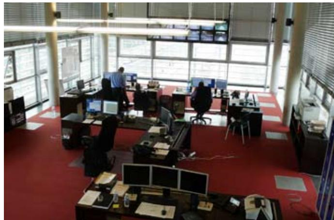
Le PCC gère l'exploitation du réseau 20h sur 24, avec la régulation du trafic, la commande des itinéraires, des aiguillages, des feux de signalisation...
